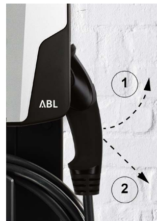
Ta bort laddningskoppling från EVSE 8X3 (liknande illustration)
